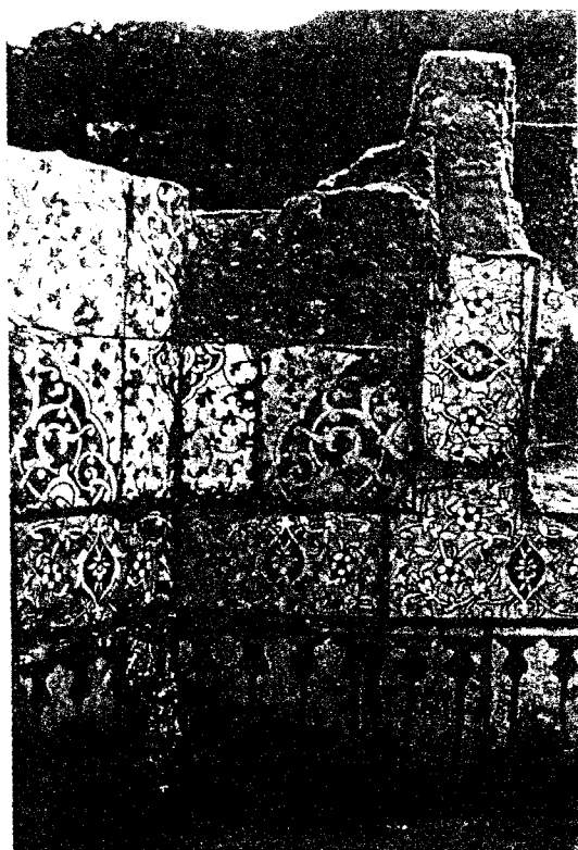
Revêtement de carreaux de faïence dans le bain du palais du gouverneur à Lahori Bandar.
